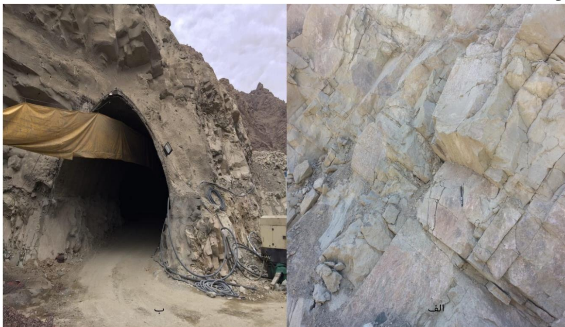
شکل (۱): الف) توده‌سنگ محل ترانشه قبل از حفاری ب) پورتال تونل
